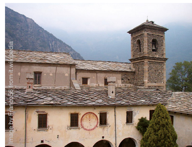
Opatství Noalesa z 12. století, kde má být zřízen systém vytápění na biomasu, který nahradí současnou neefektivní instalaci nafty.
